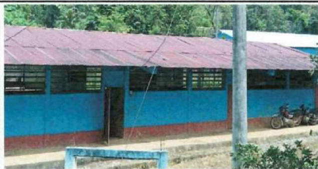
Sustitución de lamina por deterioro y filtraciones de agua a las aulas del establecimiento
