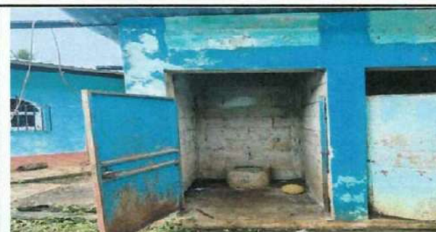
Reparacion por deterioro y oxidacion de metal material actual
