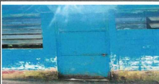
Reparacion y mantenimiento de marcos para ventanas por deterioro y oxido.
